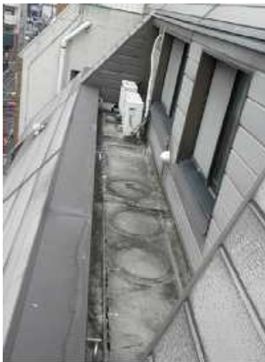
5 F道路側 防水工事施工前
