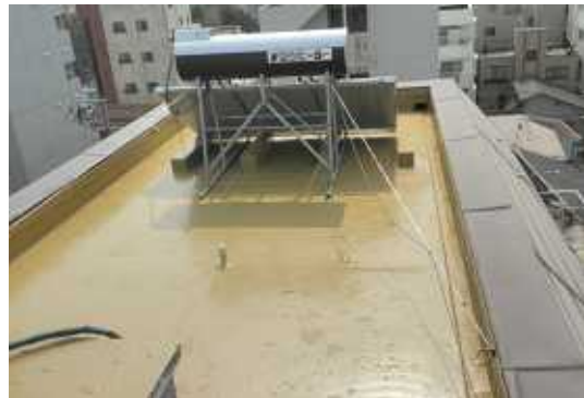
屋上2 防水工事施工後
