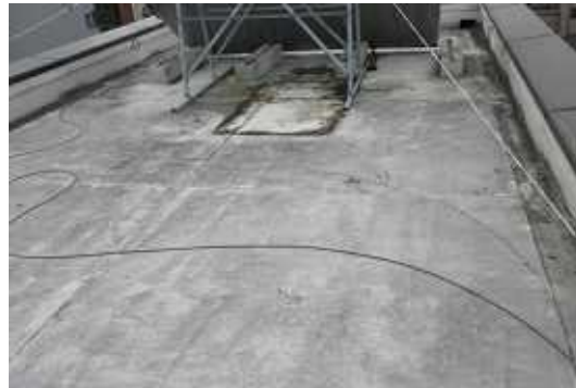
屋上2 防水工事施工前
