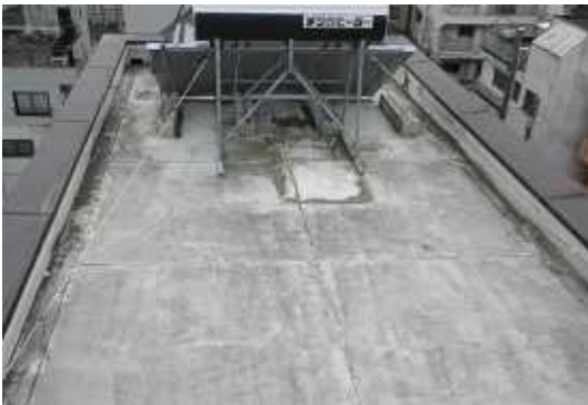
屋上2 防水工事施工前
