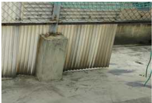
屋上3 防水工事施工前
