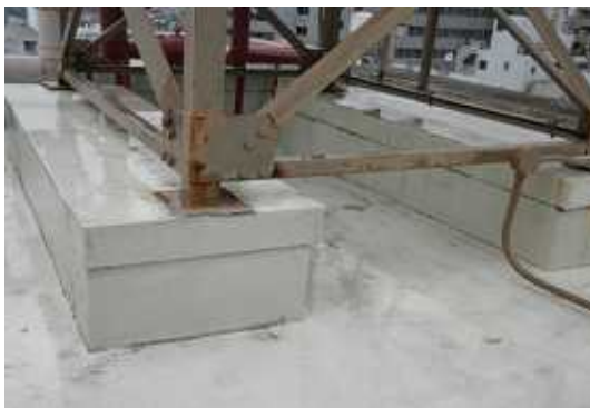
屋上1 高圧洗浄後
