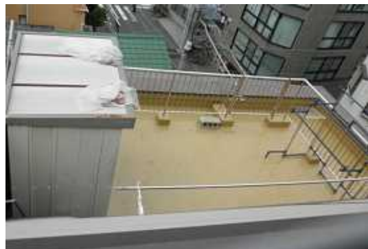
5Fベランダ 防水工事施工後
