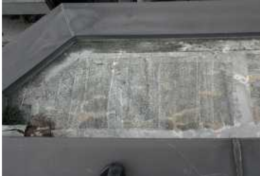
パラペット下 防水工事施工前
