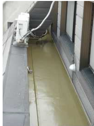
5 F道路側 防水工事施工後
