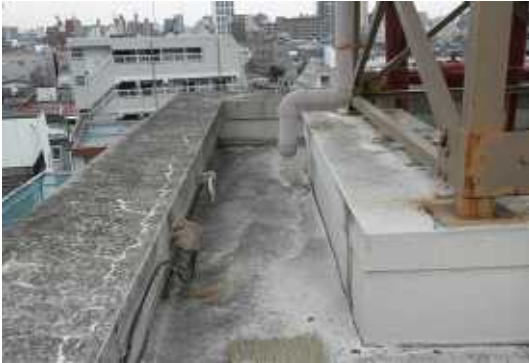
屋上1 防水工事施工前
