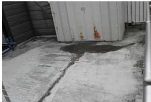
クラック補修
