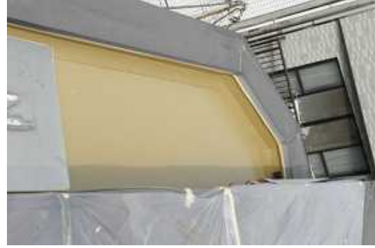
パラペット下 防水工事施工後
