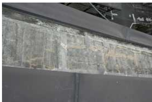
5F パラペット下防水工事施工前
