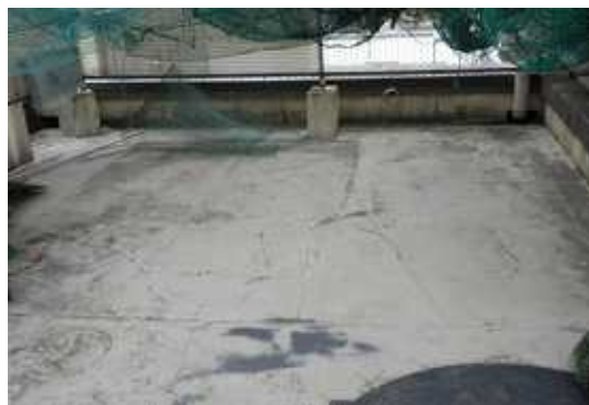
プライマー塗布
