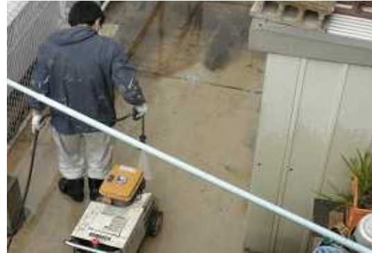
屋上3 高圧洗浄
