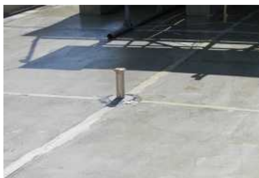
屋上2 脱気筒取付
