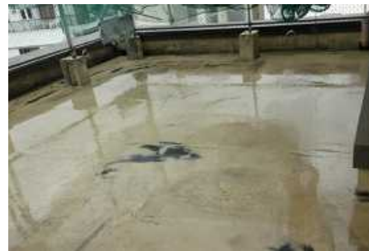
屋上3 高圧洗浄後
