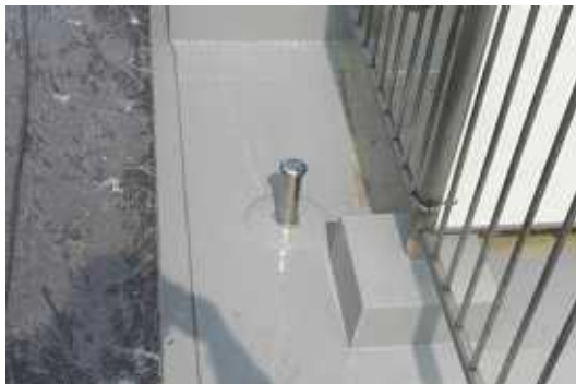
5F ベランダ脱気筒取付
