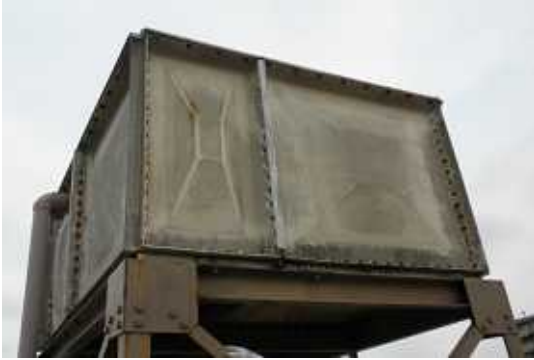
水槽タンク塗装前
