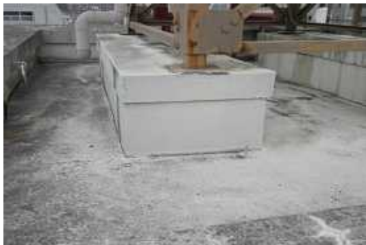
屋上1 防水工事施工前
