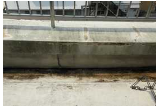
5F バルコニー防水工事施工前
