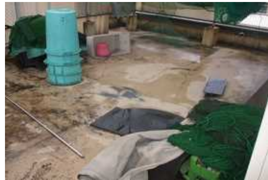
屋上1 施工前現状
