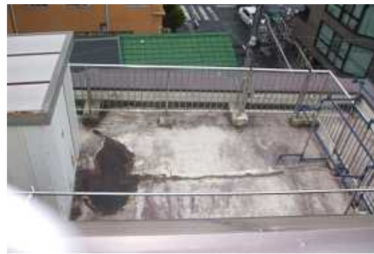
5F 右ベランダ 施工前現状
