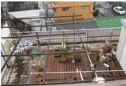
5F ベランダ 施工前現状
