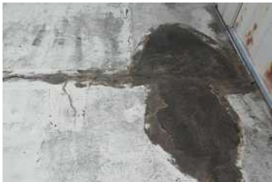
クラック補修
