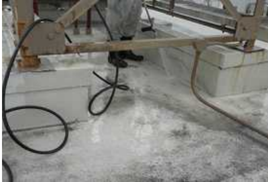
屋上1 高圧洗浄
