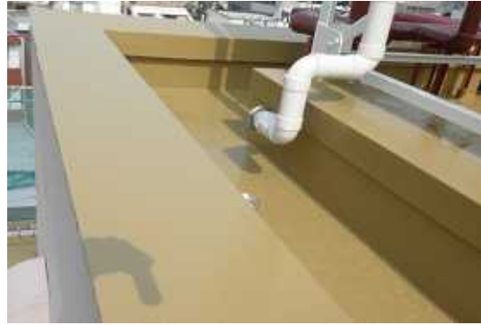
屋上1 防水工事施工後
