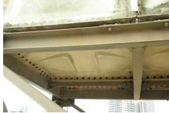
水槽タンク塗装前
