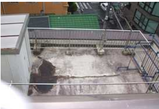
5Fベランダ 防水工事施工前
