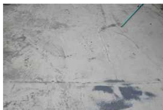
下地処理・ケレン後
