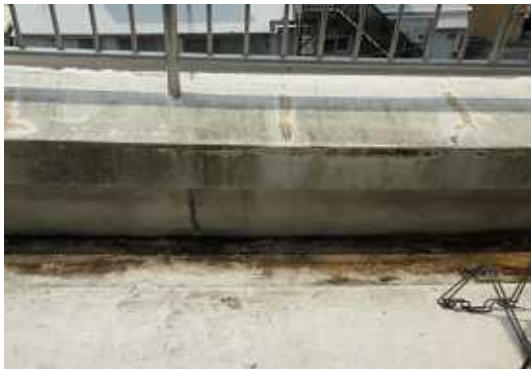
5 Fバルコニー 防水工事施工前
