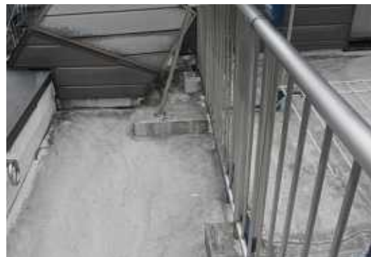
5F右ベランダ防水工事施工前
