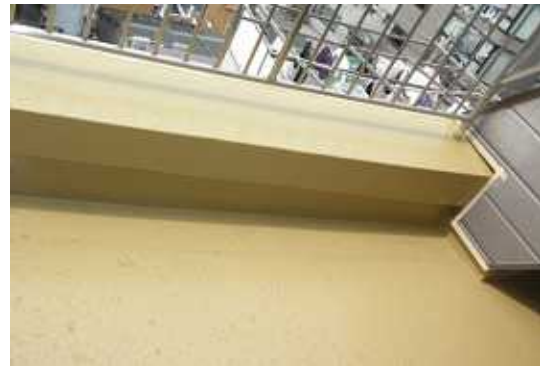
5 Fバルコニー 防水工事施工後
